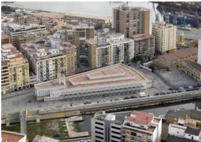
Imagen 10: Centro de Arte Contemporáneo de Málaga
